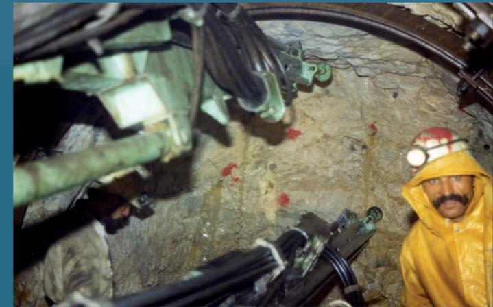
“Les trois galeries du tunnel ont été percées au moyen d'explosifs par volées de 3 mètres comportant chacune 30 à 40 trous. Ces trous de mines ont été forés à l'aide d'un jumbo à trois marteaux.”
