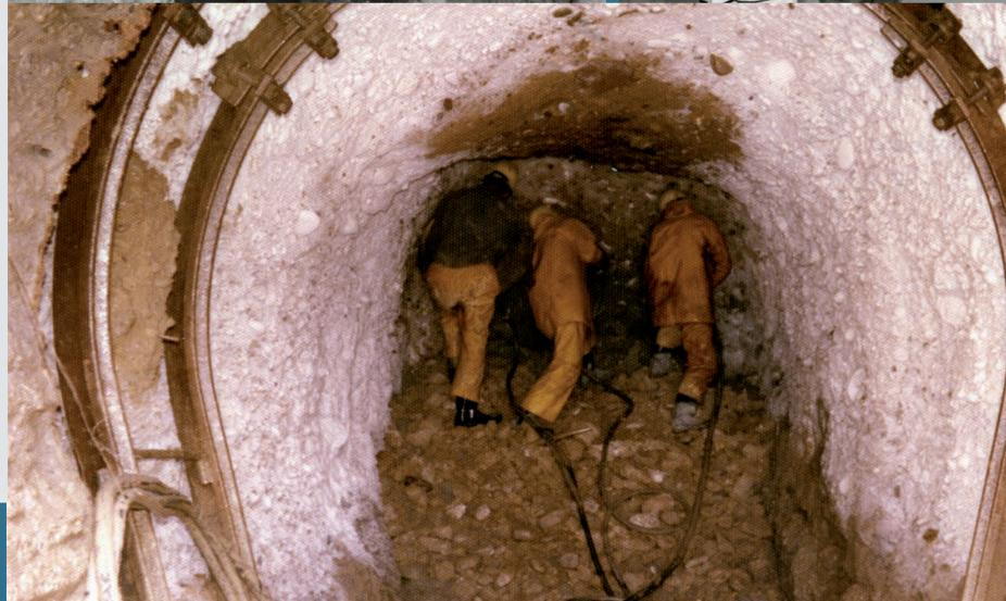
*Congélation des terrains par de l’azote liquide en tête amont de la galerie, au Bourget-du-Lac*
