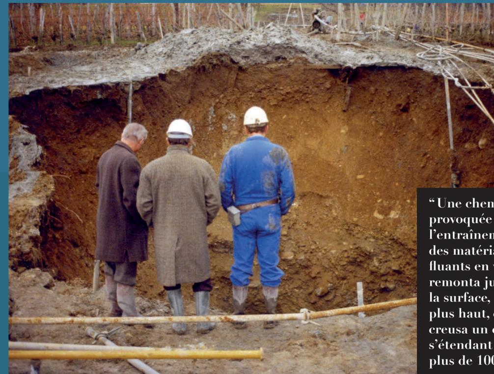
*“ Une cheminée, provoquée par l'entraînement des matériaux fluants en voûte, remonta jusqu'à la surface, 18 m plus haut, et y creusa un cratère s'étendant sur plus de 100 m². ”*
